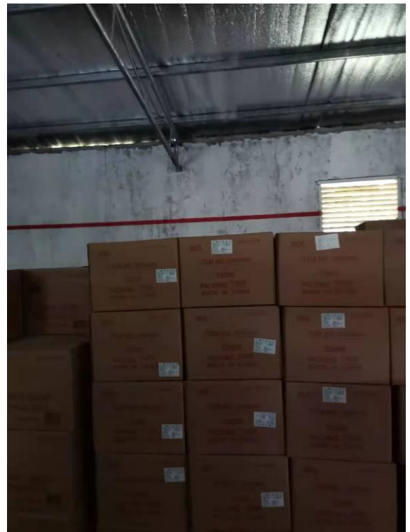
整改后：产品堆垛高度超过 2.5 米部分已移除
