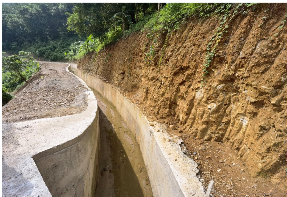
图 2.10-12 右支沟截洪沟
