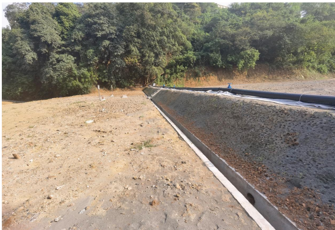
图 2.10-3 初期坝坝面排水沟
