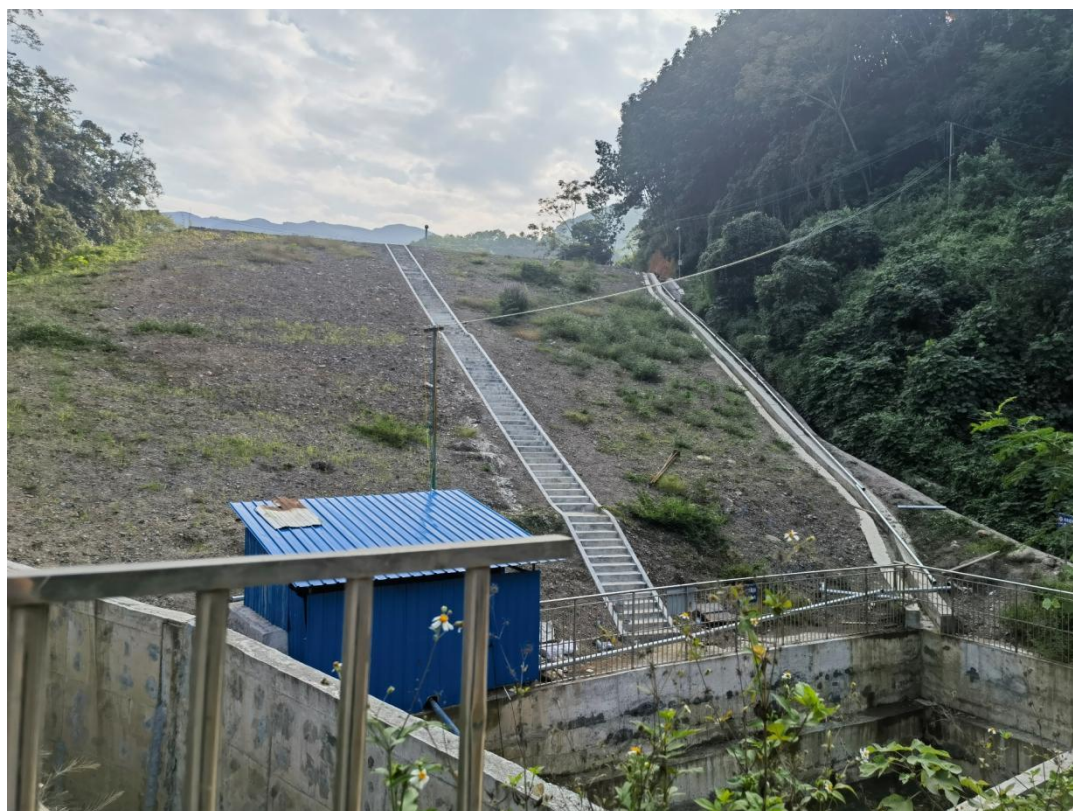
图 2.10-2 初期坝与集水池
