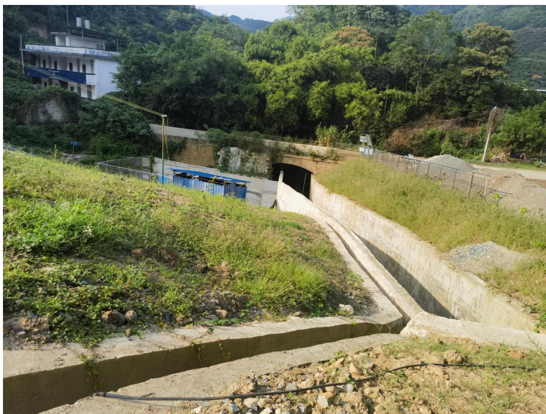
图 2.10-8 初期坝坝肩排水沟
