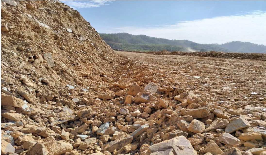
图 2-7 安全平台排水沟
