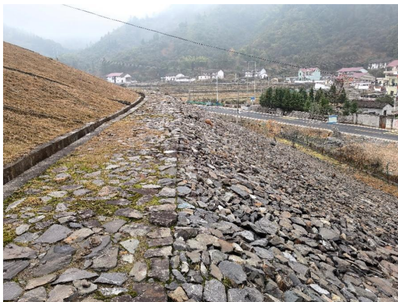
图 2-3 小龙钨业尾矿库初期坝现状图
