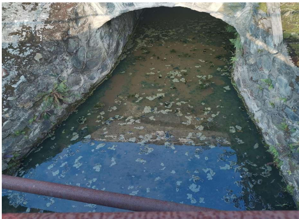
尾矿库排洪系统出口现状图
