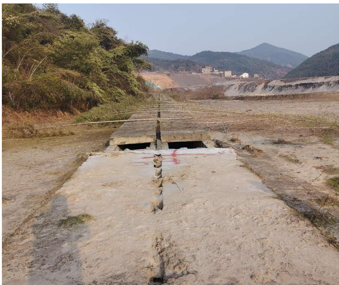
尾矿库排洪系统及滩面现状图
