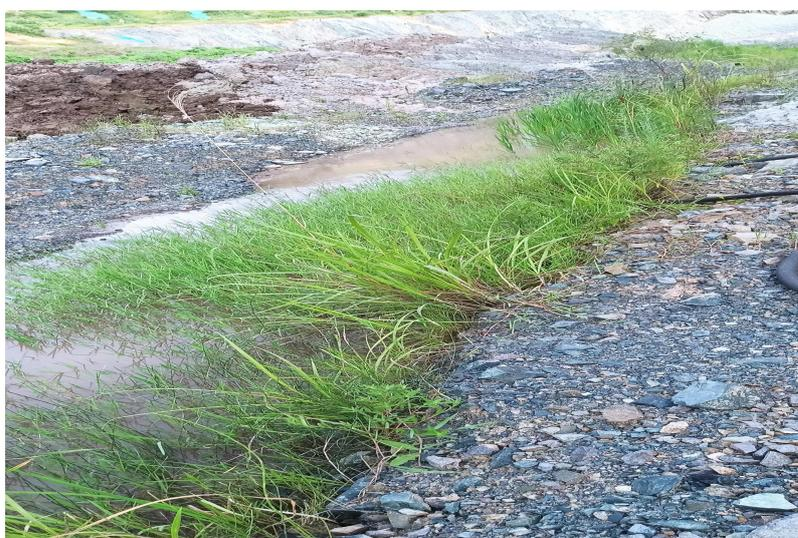
图 2-20 凹陷采坑排水堑沟
