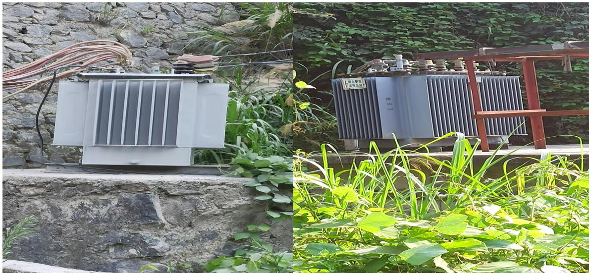
图 2-15 S<sub>11</sub>-630/10 变压器图 2-16 S<sub>11</sub>-1250/10 变压器
